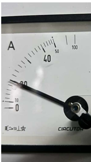
Figura 2-21. Detalle del amperímetro
